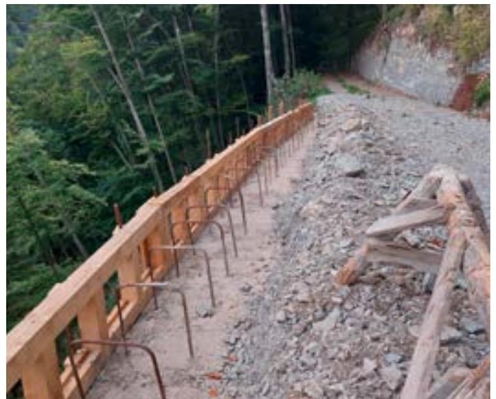
Schalungsarbeiten vor dem Betonieren der Absturzsicherung
